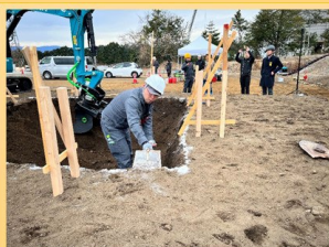
端部はスコップを用いて人力作業
