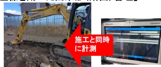
②3D-MG施工 + ②刃先による計測
