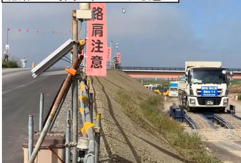
泥落とし時間のランプによる通知
