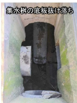
老朽化した横断排水路(コルゲート管)
