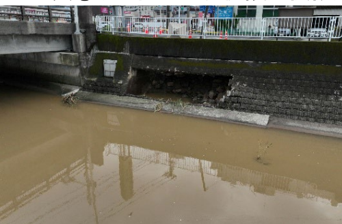
◆写真②(A1橋台下流側護岸損傷)
