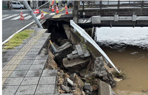
◆写真①(A1橋台上流側吸出し部)
