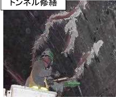
ひび割れ注入による補修
