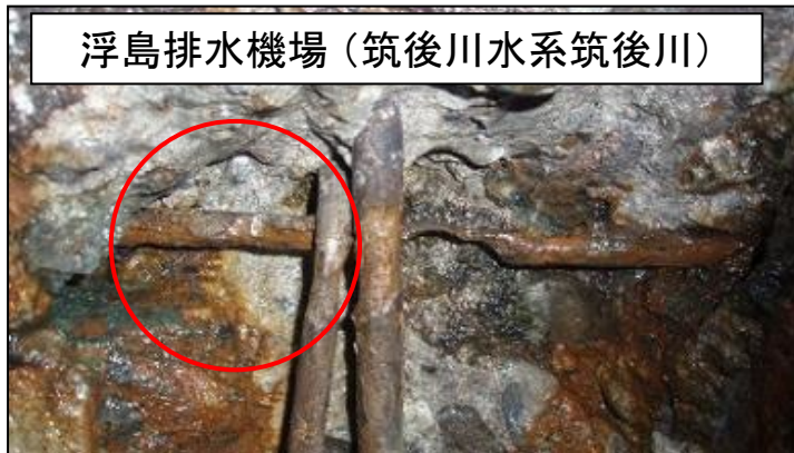
断面欠損の著しい鉄筋腐食 昭和26年設置（67年経過：H30年）
