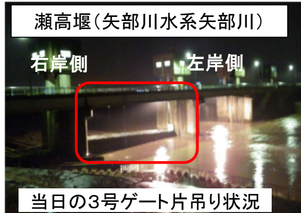
巻き取りドラムから左岸側ワイヤロープが抜け落ちて 引き上げ不能となった堰のゲート（H25年6月）
